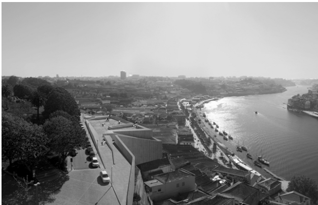
Téléférique, Vila Nova de Gaia, C.Guedes/F.Vieira Campos, en construction Funiculaire "Guindais", Porto. A. Dias. 2005
