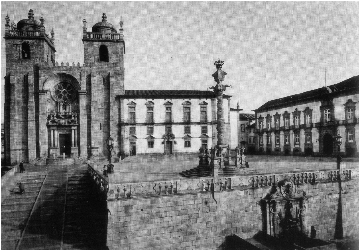
Situation actuelle (après les travaux de des Monuments Historiques)
