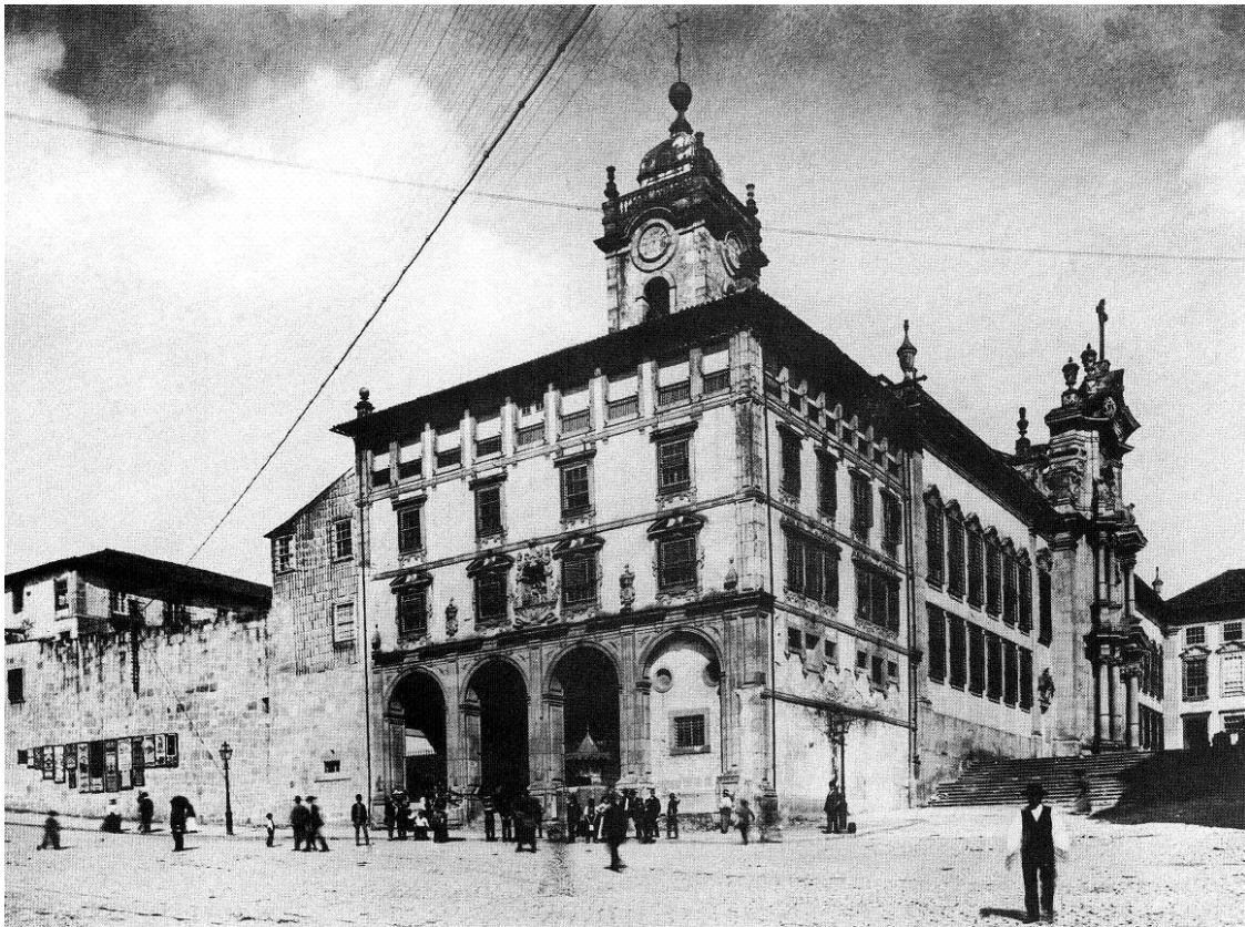
Avant : Ancien couvent de São Bento de Ave-Maria (photographie Alvão, environ 1900)
